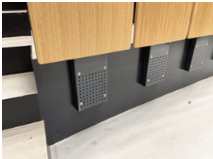
ST 49 die tragende Mittelsäule, dient als Lüftungsauslass
