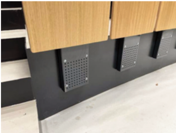
ST 49 die tragende Mittelsäule, dient als Lüftungsauslass
