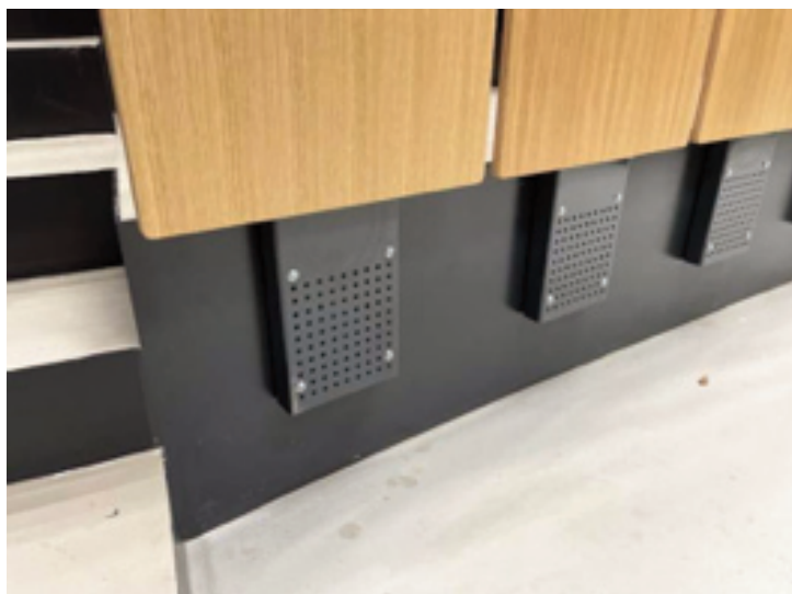
ST 49 die tragende Mittelsäule, dient als Lüftungsauslass
